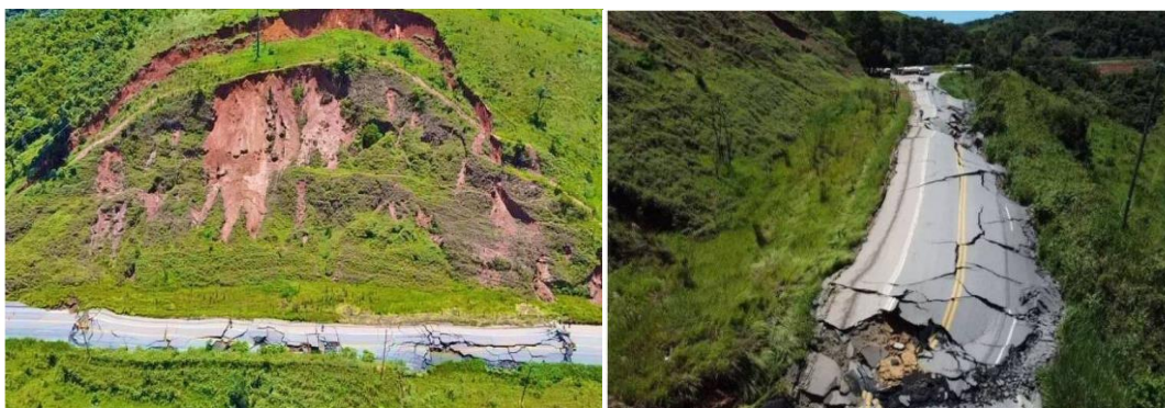
Figura 2 – Deslizamentos na Vila São Sebastião, BR-381
