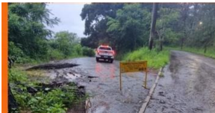
Figura 4 – Deslizamento na rua Marataízes
