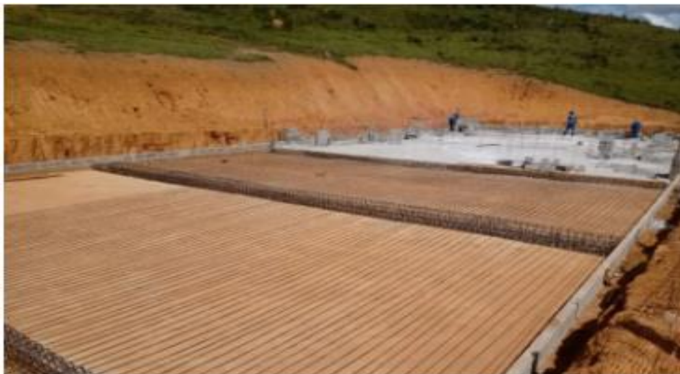
Figura 15: Obras sendo executadas pela COPASA.
