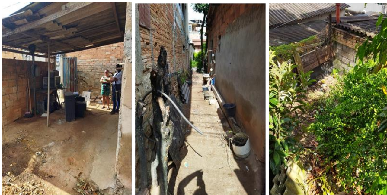
Figura 13: Situação da residência do caso 2, APÓS a limpeza. Março de 2022 (Imagens: Samira Diniz).
