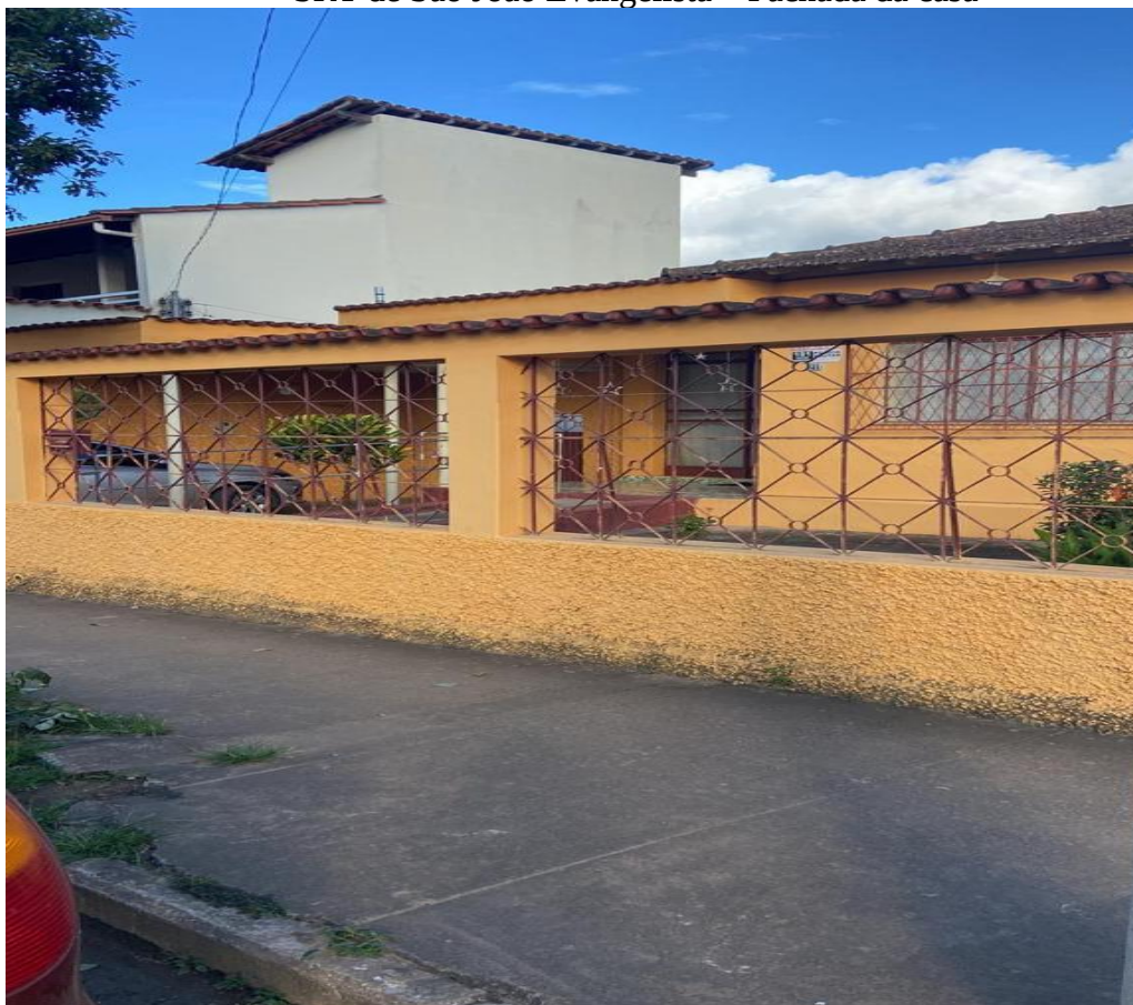
IMAGEM 16 SRT de São João Evangelista – Fachada da casa
