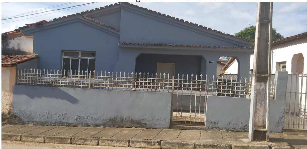
IMAGEM 15 SRT de Água Boa – Fachada da casa
