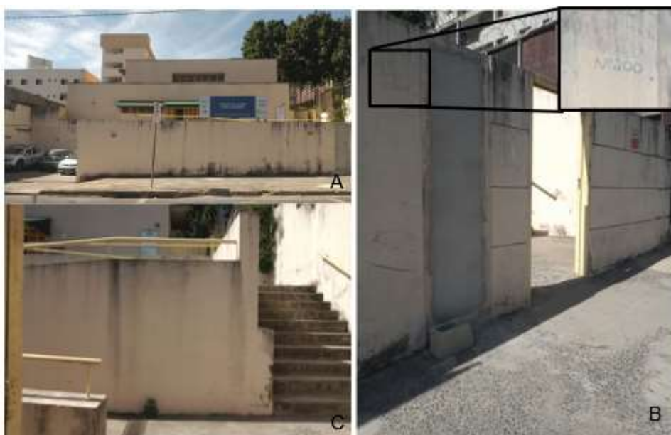
Figura 4 - A unidade. A- Visão externa da unidade. B- Entrada para pedestres. Destaque feito para a numeração da unidade, manual. C- Acesso para o 1º Pavimento pelas escadas (em frente) ou pela rampa, à esquerda. (Arquivo pessoal)
