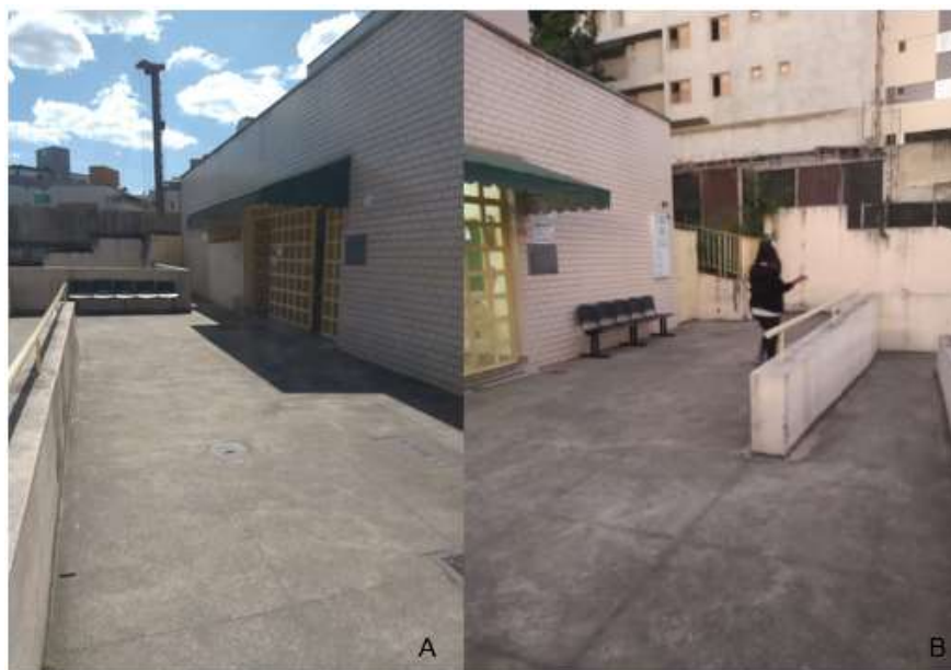
Figura 6 - Área externa frontal da unidade. A- Visão de quem sobe pelas escadas. B- À direita, na imagem, vê-se o lance final da rampa de acesso. Longarinas não apresentam posição fixa. (Arquivo pessoal)
